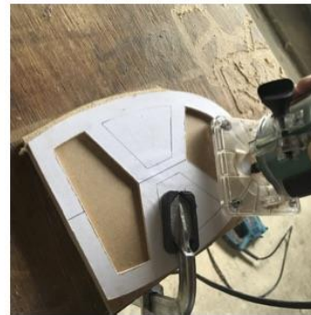
治具を使いトリマーで 倣い加工。
